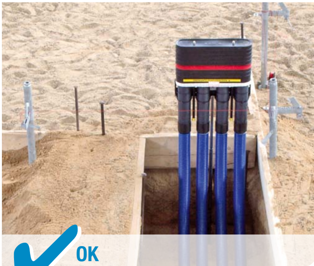
Abb. 2: Einbau einer Mehrspartenhauseinführung
