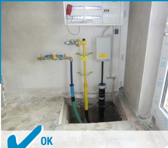
Abb. 1: Aussparung in der Bodenplatte
